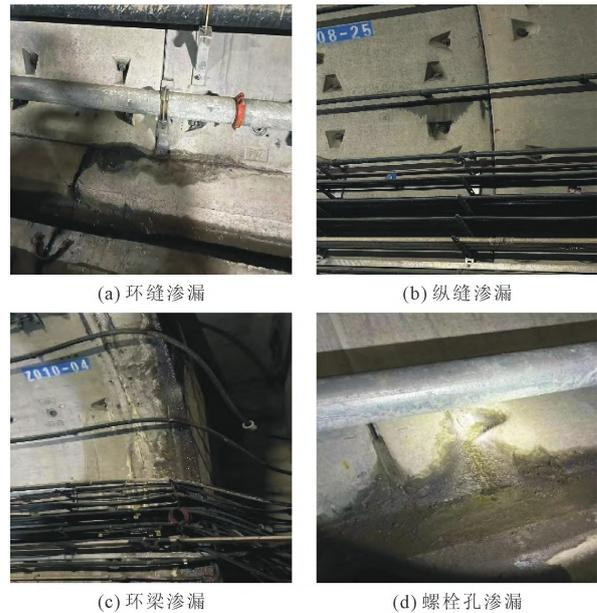
图 1 盾构隧道渗漏水位置图
