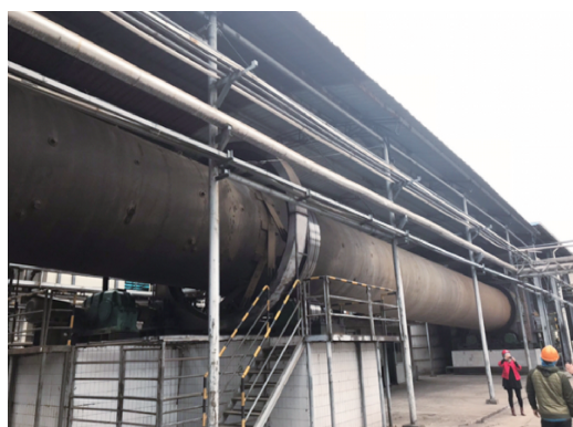
图 4 10 000 吨/年磷酸法活性炭生产线
